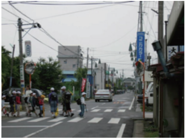
図7：歩道がなく路肩スペースが限られている道路
